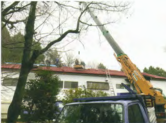
私のカフェの屋根工事(12月27日)
