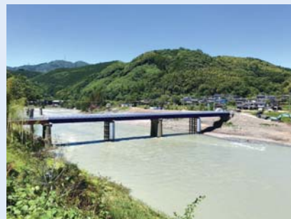
復旧した仮橋の相良橋
